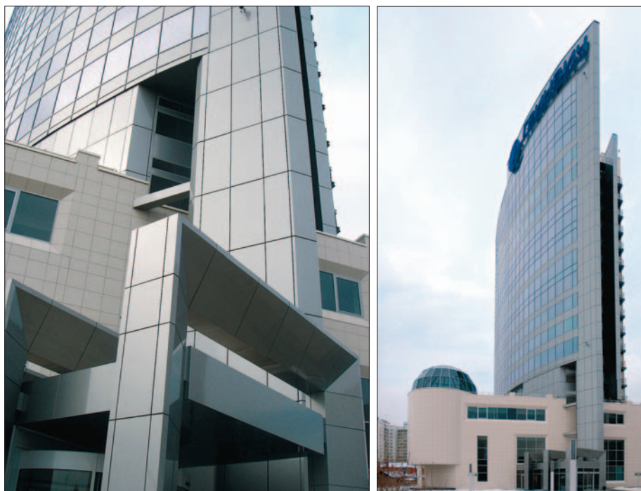
Бизнес-центр класса А «Гринвич» с помещениями общественного назначения и подземной автостоянкой (Железнодорожный район Новосибирска).
